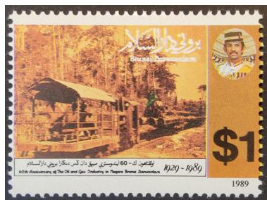
Бруней Даруссалам, 1989. 60-летие нефтяной и газовой индустрии. Перевозка труб по железной дороге для внутреннего снабжения.
